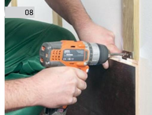
На деревянные конструктивные балки нанести клей для древесины или монтажный клей (до высоты одной доски). Первую доску (с обрезанным стыком) прижимаем к полу, прижимаем к решетке с клеем и сверху прикрепляем клипсами.
