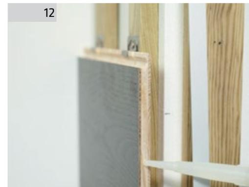
На таким образом срезанный угол, на стыке досок наносим монтажный клей.
