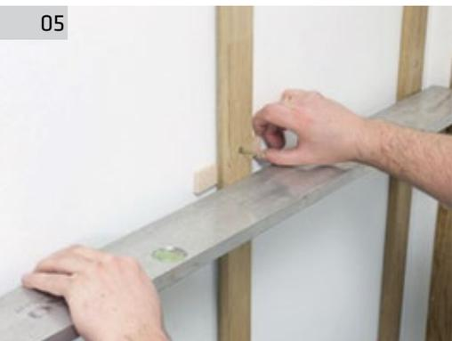
Рейки должны создавать одну плоскость. Это следует проверить с помощью уровня, прикладываемого на ширине минимум 3 реек. При необходимости выровнять конструкцию, используя, например, фанеру.
