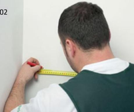
Отметьте места, в которых будут прикреплены деревянные конструктивные рейки с минимальными размерами сечения 18 мм x 50 мм. Первую рейку прикрепите на расстоянии максимум 10 см от внутреннего или внешнего угла.
