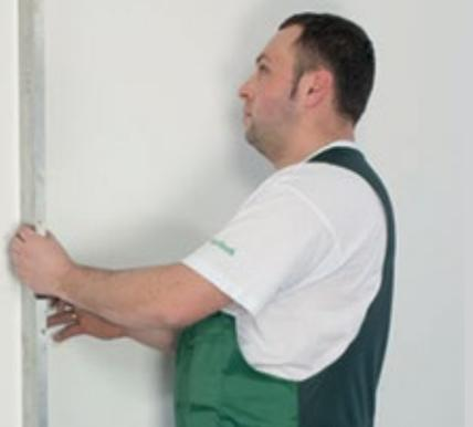
Проверьте уровень стены с помощью уровня. Отклонение не должно превышать 2 мм на длине 2 м.
