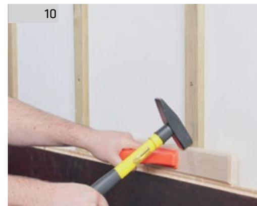
Соседние доски соединяем друг с другом с помощью замков - добивая их друг к другу.
