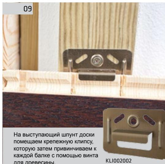
На выступающий шпунт доски помещаем крепежную клипсу, которую затем привинчиваем к каждой балке с помощью винта для древесины.
