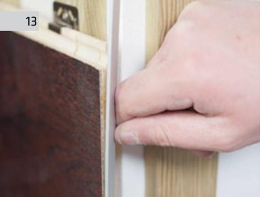
Затем в этом месте клеить, например, алюминиевую полосу, которая являет собой декоративный элемент и защищает острые края срезаемых досок. Кроме того, вы также можете использовать алюминиевые или деревянные угольники.
